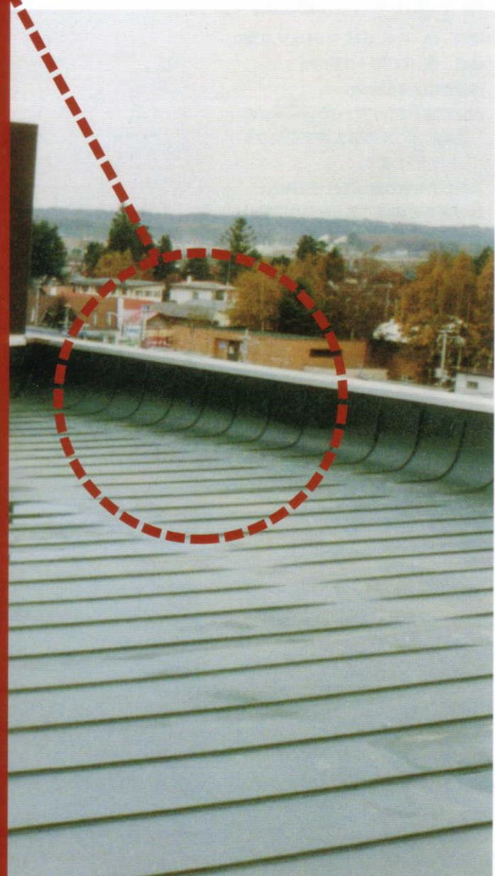
流れ方向の壁立ち上げ部分は屋根材を機械によるR曲げ加工し、鉄を入れない施工方法のため防水性が確保されます。
